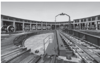
近代化産業遺産『旧津山 扇形機関車庫と転車台』
